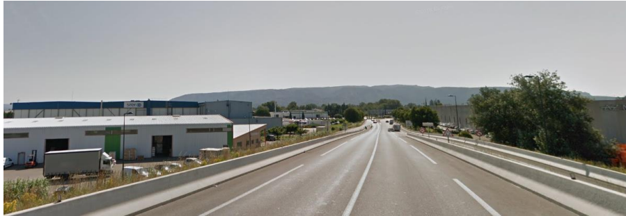
Entrée de ville Sud-Ouest avenue Boscodomini
