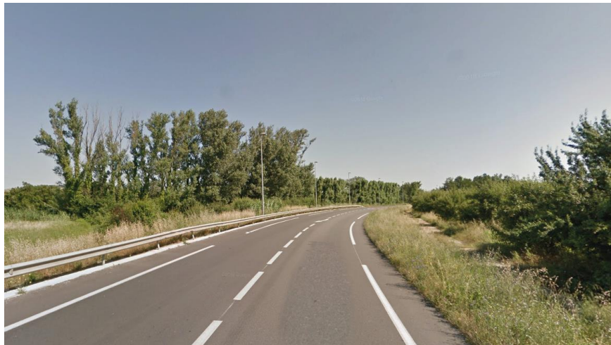
Entrée de ville Sud-Est avenue Boscodomini
