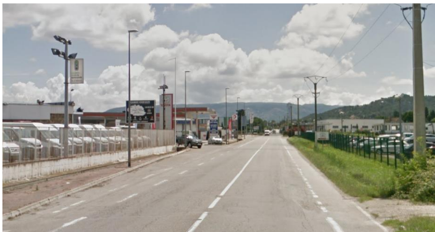
Entrée de ville Nord route d'Avignon
