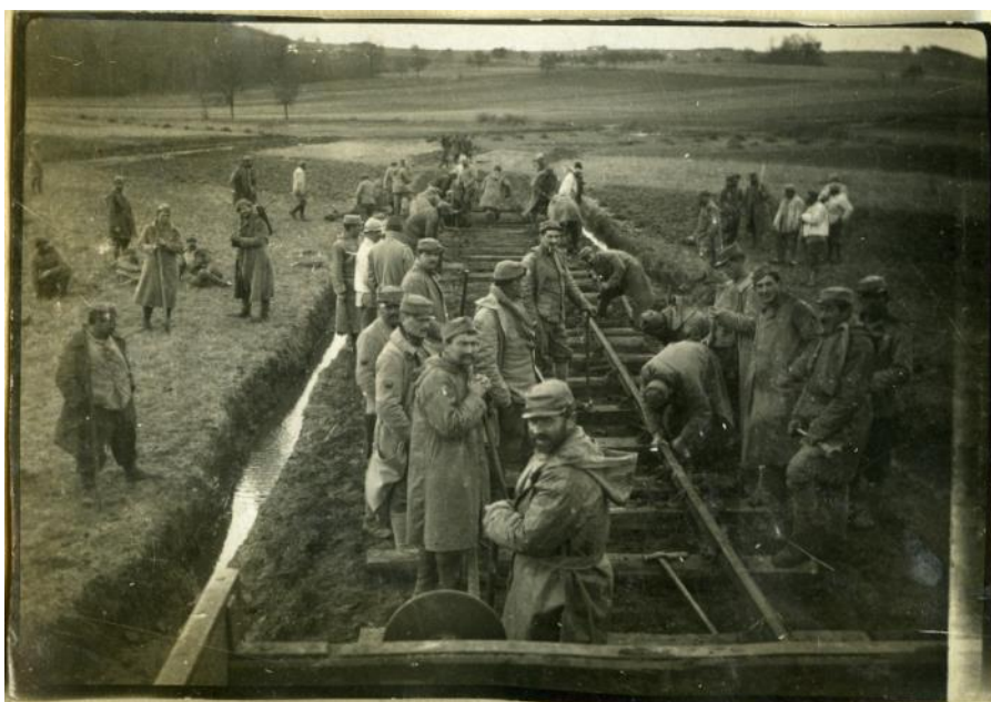
Chantier de pose de la voie, Courmont (Aisne), s. d. [1916].
