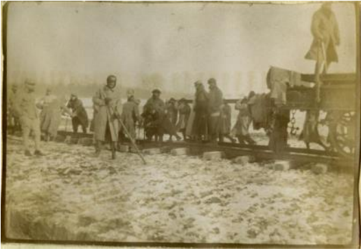
Pose de la voie à Cuvilly (près Montdidier, Oise), 2 février 1917.
